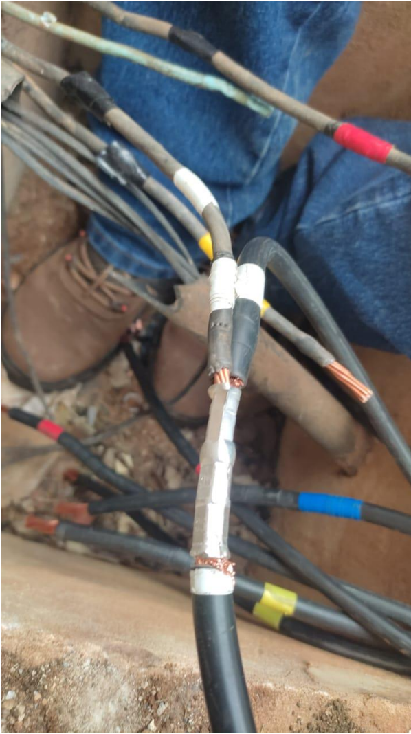
Conexões c/ conectores tipo “luvas” prensado com alicate hidráulico
