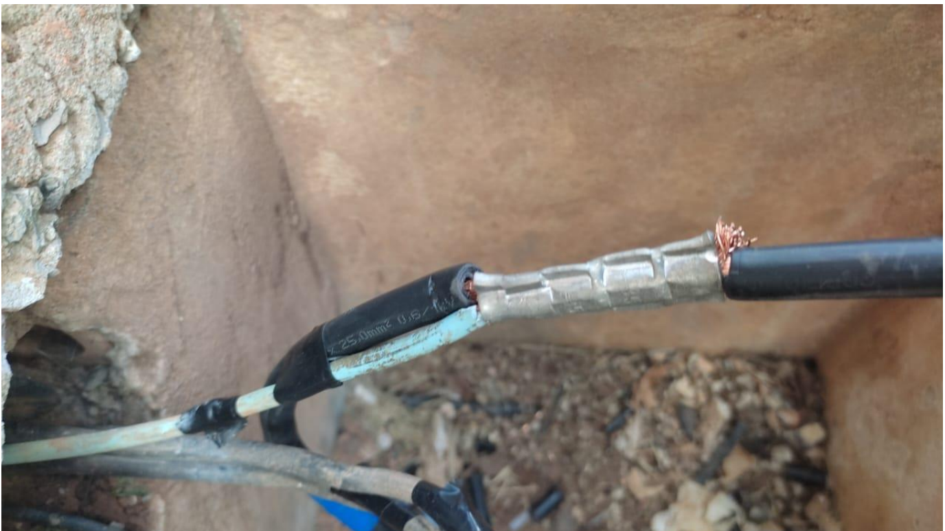
Conexões c/ conectores tipo “luvas” prensado com alicate hidráulico
