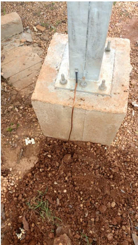
Aterramento Pilar Estrutura Carport
