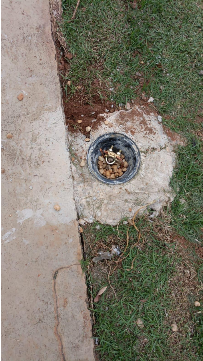
Caixa de Inspeção Aterramento (Lateral Casa Abrigo)
