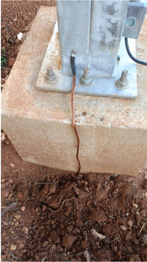
Aterramento Pilares Estrutura Carport
