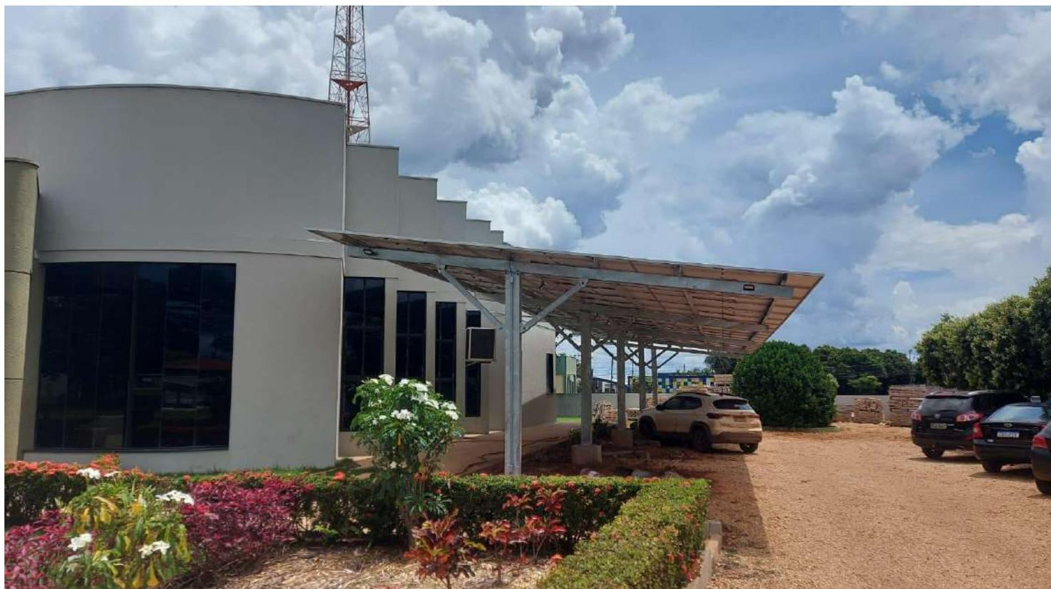
Estrutura Carport concluída com 60 de 550W Painéis Fotovoltaicos Instalados
