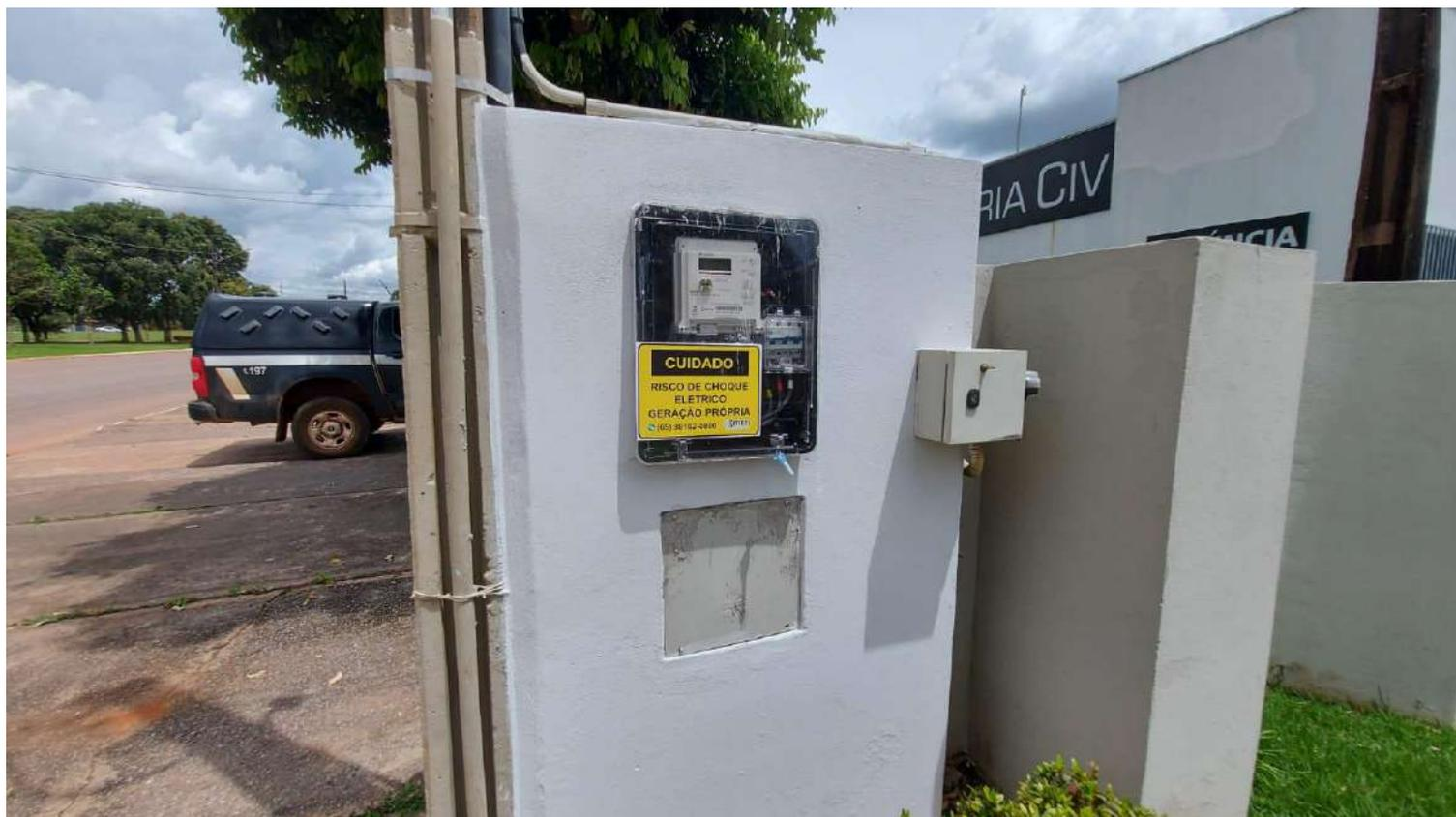
Padrão de Entrada readequado, com novo medidor instalado pela concessionária de energia
